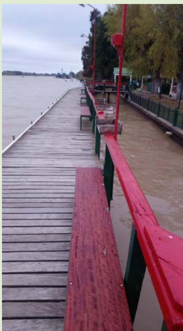
Diferentes trabajos en el muelle
