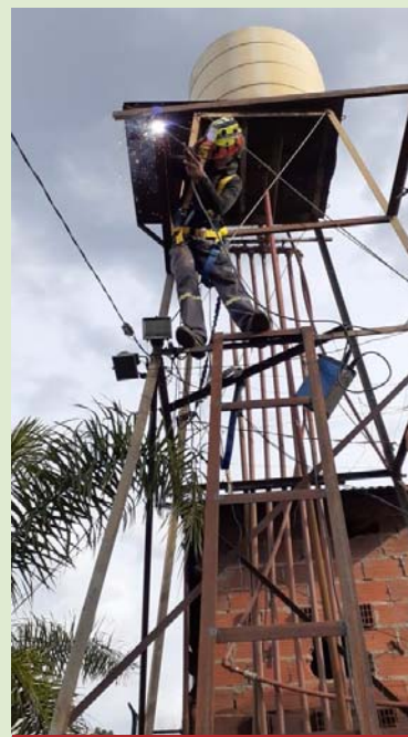
Escalera para acceder al tanque de agua
