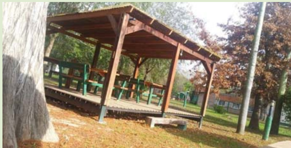
La nueva pérgola, con bancos y mesas (obra de agosto 2019)
