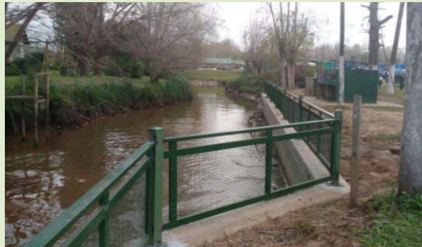
Estacada sobre canal el "mosquito"
