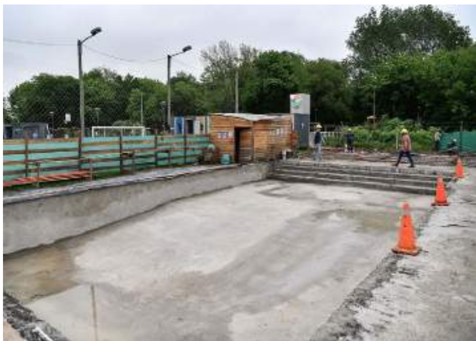
Así van los trabajos en el natatorio del polideportivo lomaverdense
